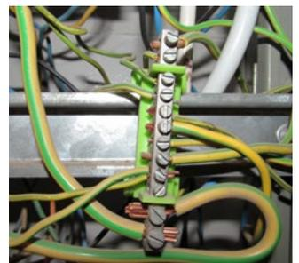
In Kombination mit alten Elektroleitungen im Haus können durch den hohen Strombedarf von Elektroheizkörpern Brandgefahren entstehen, langandauernde hohe Belastung der Elektroleitungen im Haus kann bei schlechten Kontakten in Verteilerdosen einen Schwelbrand verursachen.
